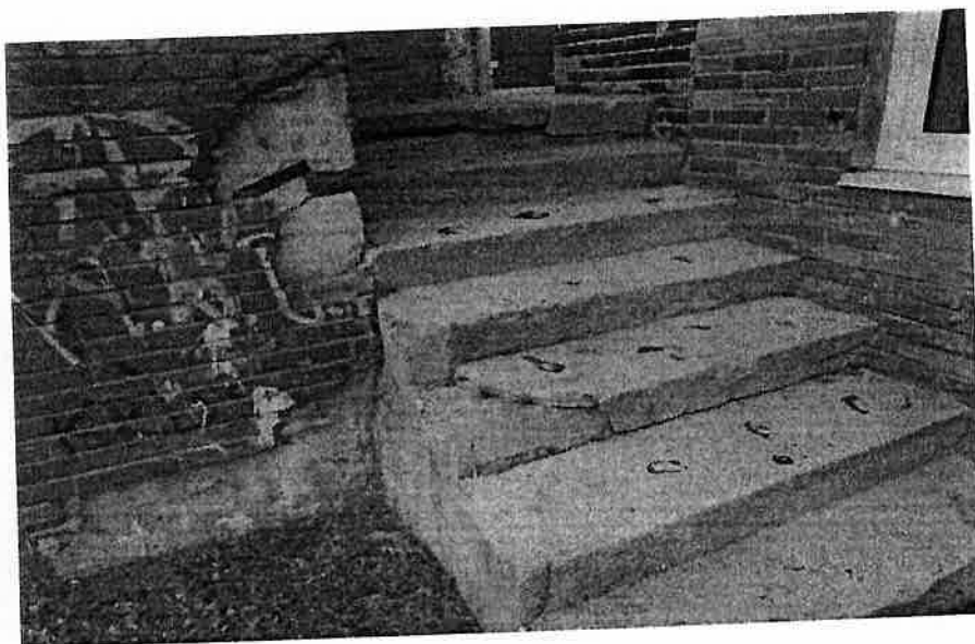
Foto nr 55. Zniszczone schody od zaplecza budynku.
