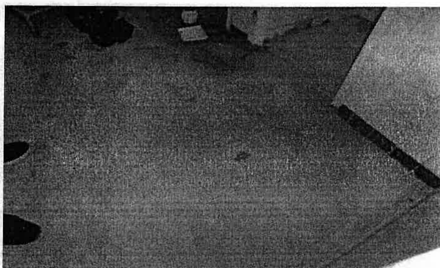
Foto nr 29. Zerwana posadzka w pom. sanitarnym.
