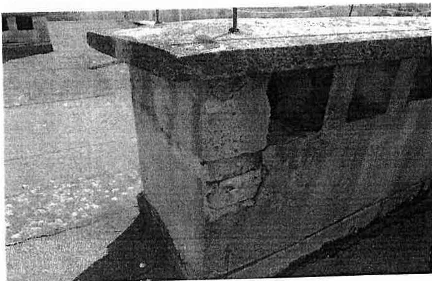
Foto 7. Uszkodzenia tynku na kominach .
