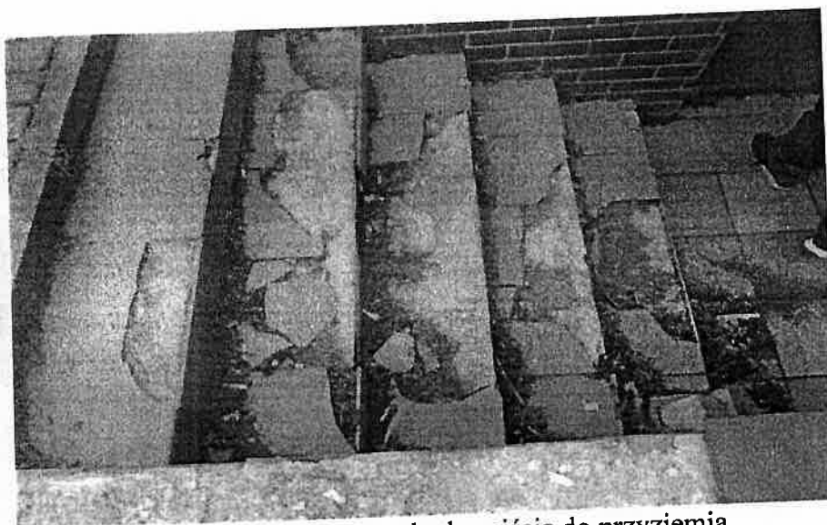
Foto 49. Zniszczone schody zejściowe do przyziemia .
