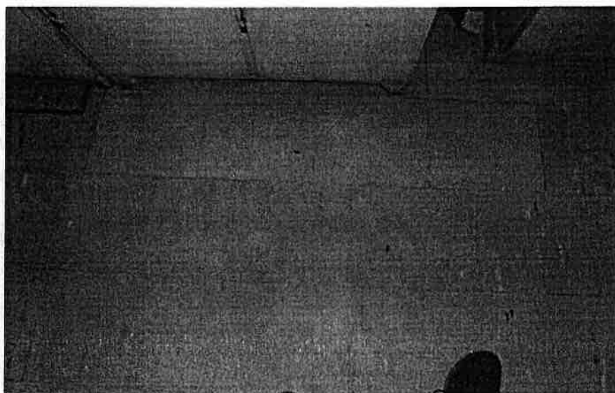
Foto 28. Mocno zużyte posadzki z płytek PCV.
