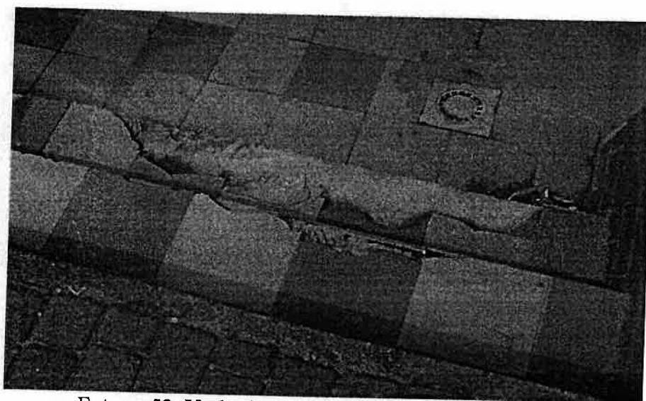
Foto nr 53. Uszkodzone schody do przyziemia.
