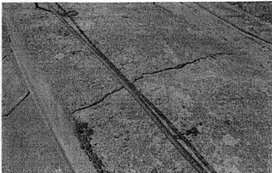
Foto 4. Pęknięcia czapek kominowych .
