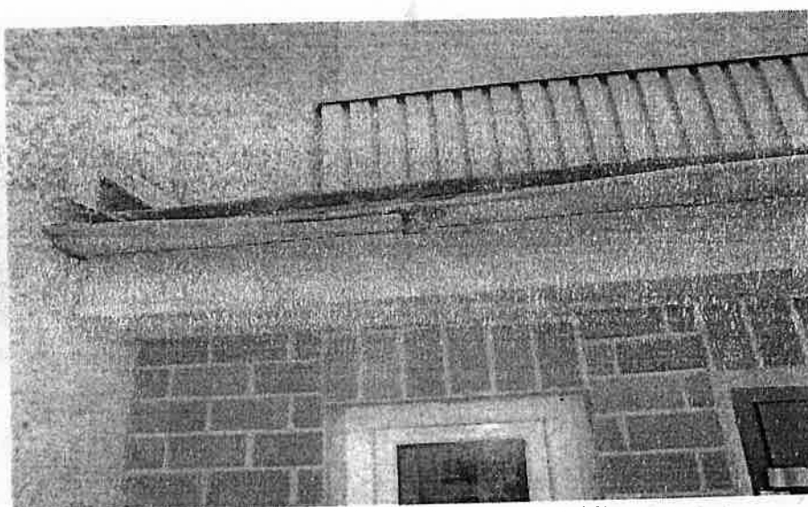
Foto nr 8. Uszkodzona rynna nad daszkiem.
