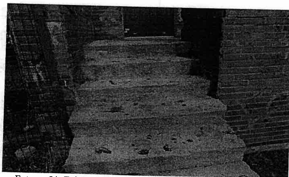
Foto nr 54. Zniszczone schody od zaplecza budynku.
