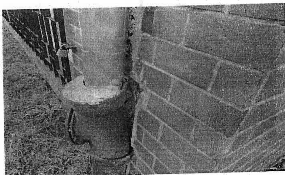
Foto nr 9. Uszkodzony wpust rury spustowej.
