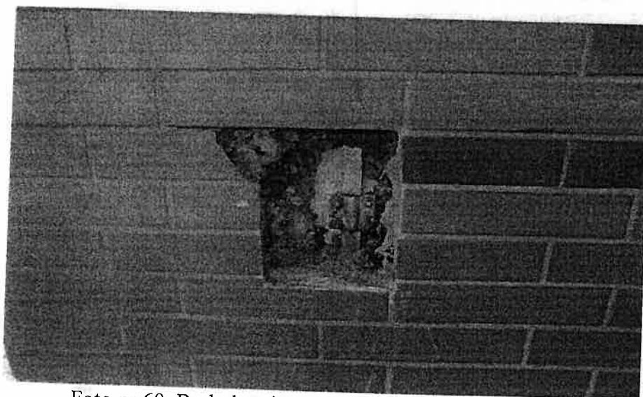
Foto nr 60. Brak drzwiczek złącza odgromowego.
